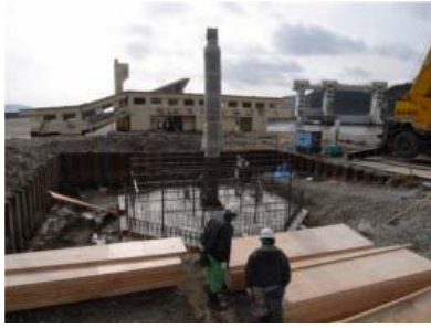
幹の1段目の設置
