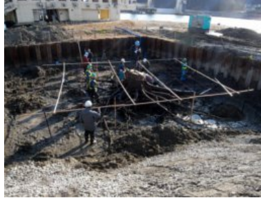
抜根作業 全景
